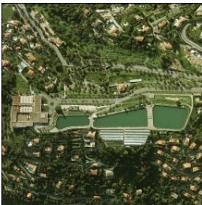
La station de traitement des eaux de Rimiez
